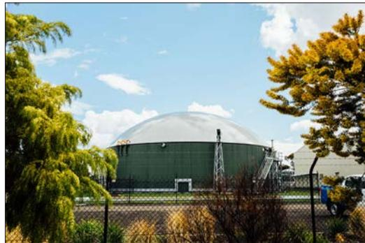
*Zu Beginn der Wartungsarbeiten werden die Tanks zunächst vollständig entleert. Außerdem werden die Dächer der beiden 3.573 Kubikmeter fassenden Fermenter aus Edelstahl sowie interne Anlagenteile wie etwa die Rührtechnik erneuert.*
