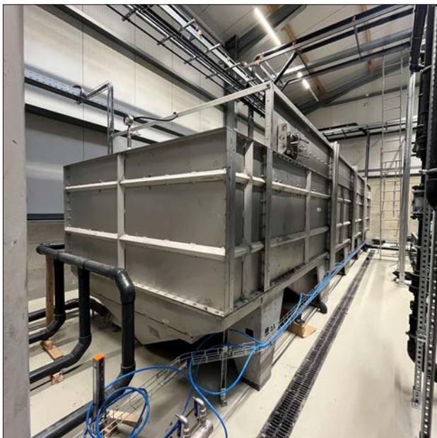
*Die verbliebene flüssige Phase wird zunächst in einem rostfreien Flotationsbecken belüftet. Dadurch reagieren kleine Partikel und Schwebstoffe und setzen sich am Beckenboden ab. Dieser Schlamm wird wiederum dem Aufbereitungsverfahren zugeführt. Die übrigen festen Bestandteile der flüssigen Phase werden durch einen Filter abgeschieden.*
