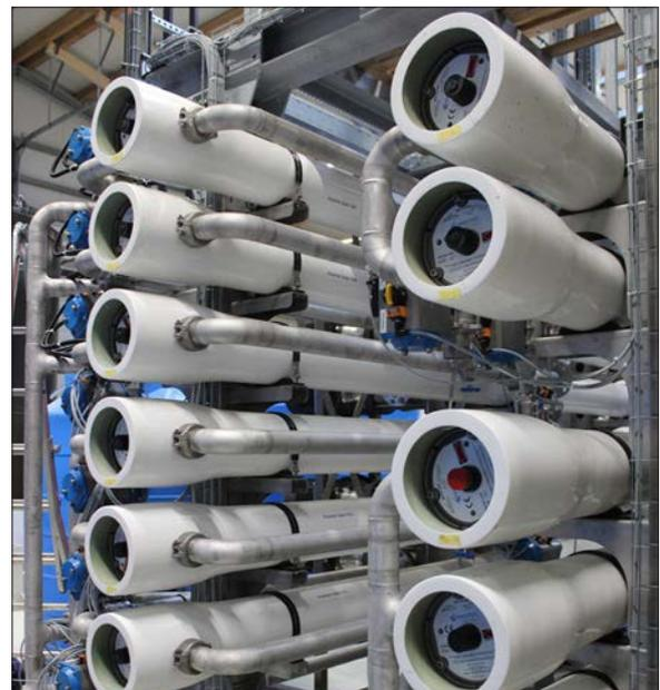
*Im abschließenden Verfahrensschritt wird eine dreistufige Umkehrosmose angewendet. Die verbliebene flüssige Phase ist bereits stark gereinigt. Die halbdurchlässigen Membranen bei der dreistufigen Umkehrosmose können 95 bis 99 Prozent der gelösten Salze und Nährstoffe abscheiden. Das abgeschiedene Nährstoffkonzentrat kann als leicht zu transportierender Flüssigdünger genutzt werden.*
