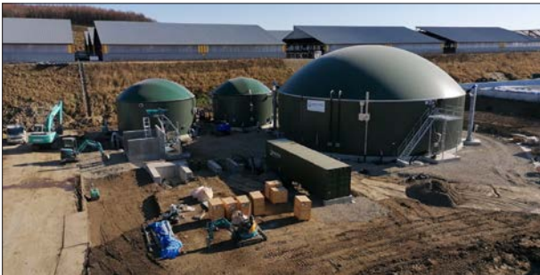
Im Sommer 2021 geht die 250-Kilowatt-Biogasanlage in Urahoro auf Hokkaido in Betrieb.
