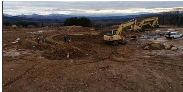
In Sakata auf der Hauptinsel Honshu entstehen neben der Biogasanlage derzeit auch Kuhställe. Im Herbst 2021 soll dieser Standort fertig sein.
