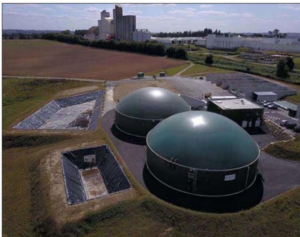
Erst kürzlich hat der Biogasanlagenhersteller WELTEC BIOPOWER eine Biomethananlage für den französischen Kartoffelchips-Produzenten ALTHO in St. Gérard, Bretagne, fertiggestellt.
