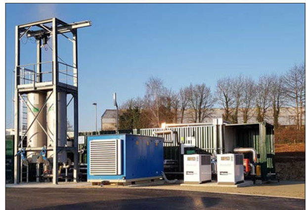
Zur Konditionierung des Biogases zu Biomethan hat WELTEC BIOPOWER eine Membrantechnik als kompakte Containerlösung integriert.
