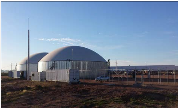
Bereits im Jahr 2013 hatte WELTEC die erste 800-Kilowatt-Biogasanlage für EDL errichtet.
