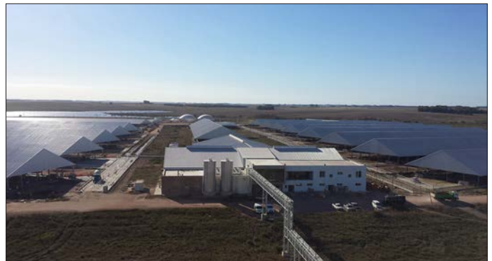
Um über ausreichend Rohstoffe zu verfügen, wurde die Anzahl von damals 8.000 auf 14.000 Kühe aufgestockt. Nun stehen täglich 1.365 Tonnen Rindergülle und zusätzlich 8,4 Tonnen Futterreste für die Energiegewinnung zur Verfügung.
