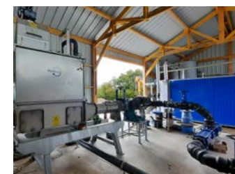
Die Positionierung des MULTIMix erfolgt zwischen Feststoffeintrag und Fermenter
