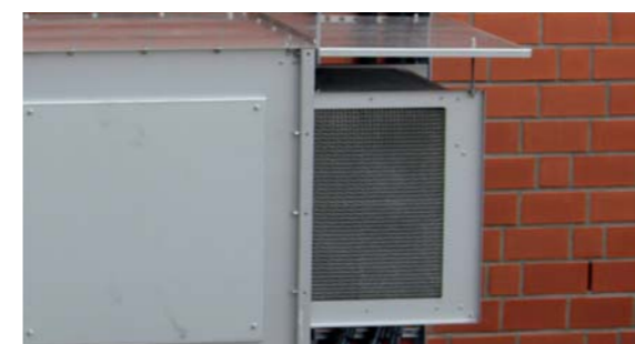
Platzsparend: Die Luft gelangt durch Filter zu Radialgebläse und Wärmetauscher.
