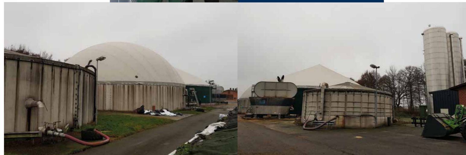
unten: 2018/2019 wurde die Biogasanlage von Uwe Heider (ganz rechts) umfangreich für die Zukunft ausgestattet. U.a. mit zwei Pufferspeichern.
