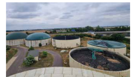
In Anlage in Barleben wurde in einem schlechten Zustand übernommen und muss aufwendig saniert werden.
