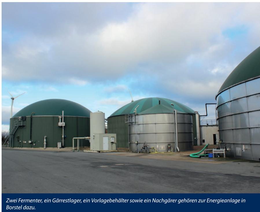
Zwei Fermenter, ein Gärrestlager, ein Vorlagebehälter sowie ein Nachgärer gehören zur Energieanlage in Borstel dazu.
