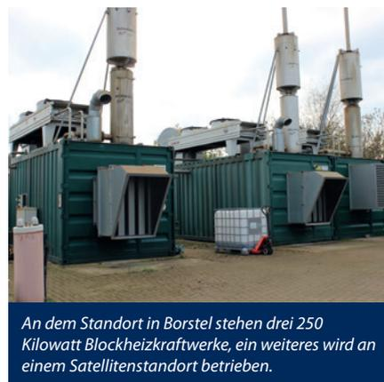
An dem Standort in Borstel stehen drei 250 Kilowatt Blockheizkraftwerke, ein weiteres wird an einem Satellitenstandort betrieben.
