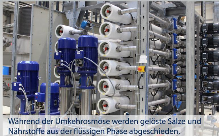
Während der Umkehrosmose werden gelöste Salze und Nährstoffe aus der flüssigen Phase abgeschieden.
