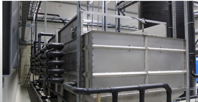
Im Flotationsbecken werden Schwebstoffe mittels Druckluft aus der flüssigen Phase als Schaum bzw. Schlamm abgetrennt.
